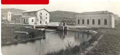
Opera di presa alle sorgenti del Sardos
