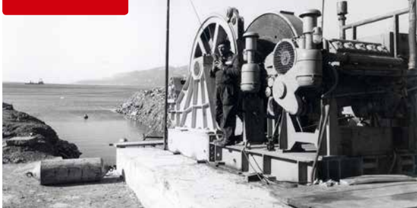
Lavori di posa condotte sottomarine
